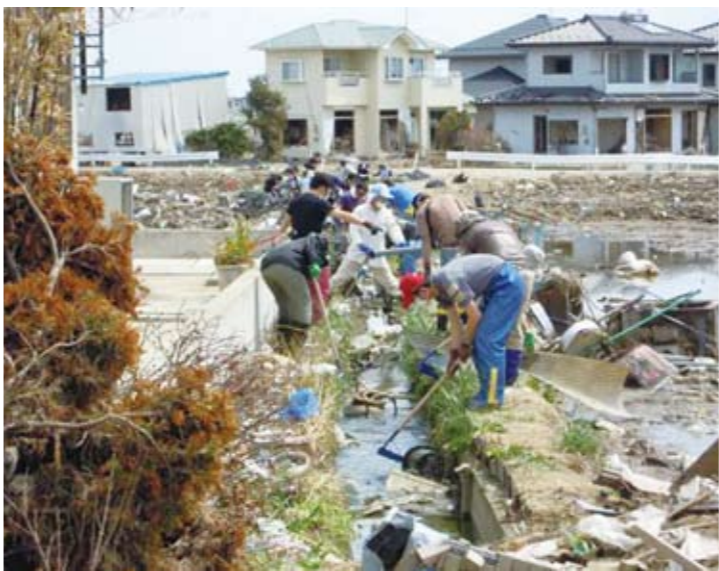
側溝のがれきを撤去する住民たち
