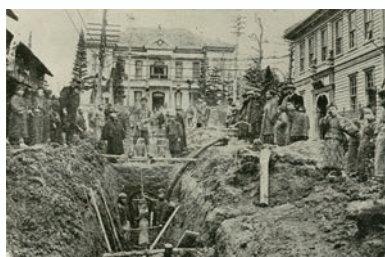
明治44年 水道鉄管敷設工事
